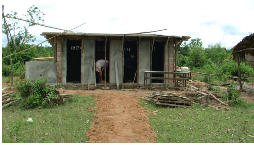
ミンカークウィン中学校:トイレ建設
