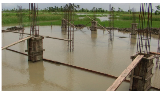
チェツシャー小学校:校舎兼シェルター建設
