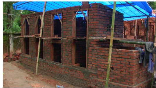
クウェルウェ中学校:トイレ建設
