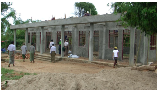
アピインイエーサイ小学校:校舎建設
