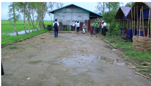
ミンカーコン中学校:倒壊した校舎跡地
