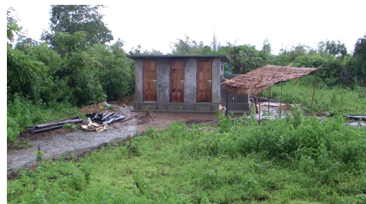
ザラクウイン小学校:トイレ建設
