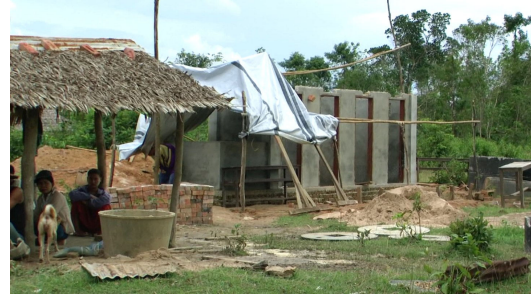
ミンカークウィン中学校:トイレ建設
