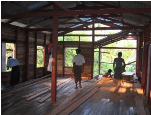
■ 校舎床・壁の修復
