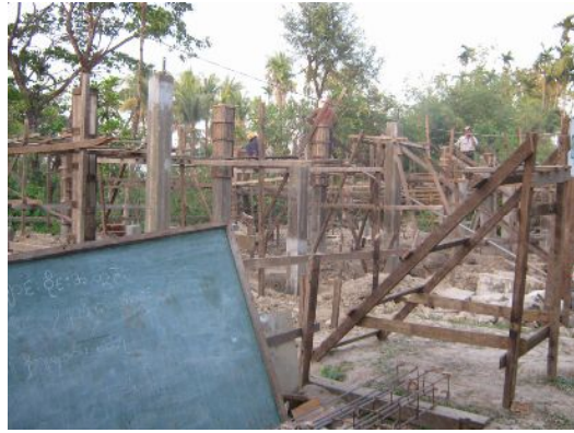
■ 支柱の建て直し
